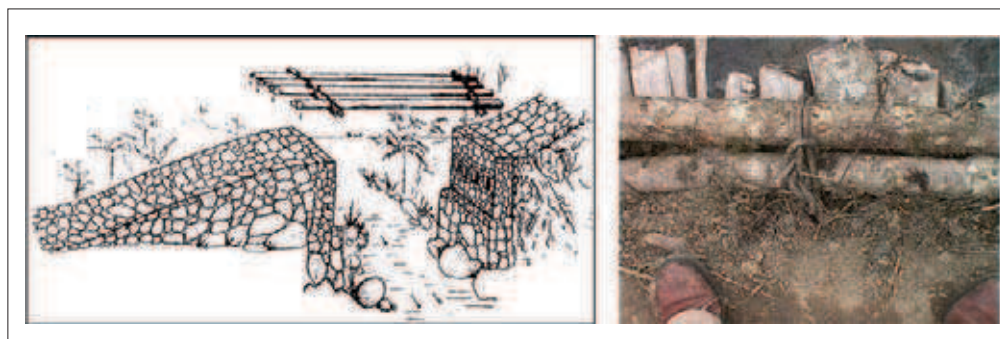
Figura 11. A la izquierda: puente Inca sobre el río San Jacinto (Céspedes 1986). A la derecha: sistema tecnológico y de amarre actual usado para la cubierta en puentes con base de piedra. Río Naranjitos-San José.
