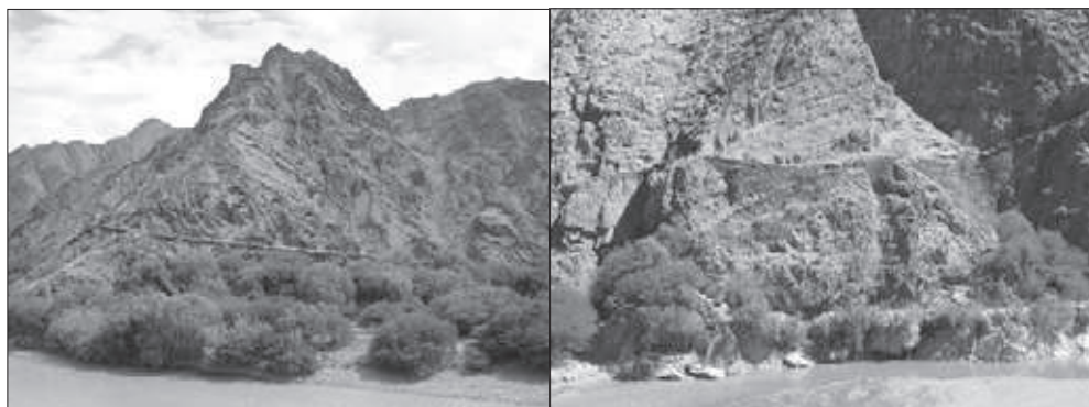
Figura 13. Camino interregional entre el valle de Cinti y Cotagaita: a) vista de un tramo en Lintaca, b) muros de contención y plataforma.
