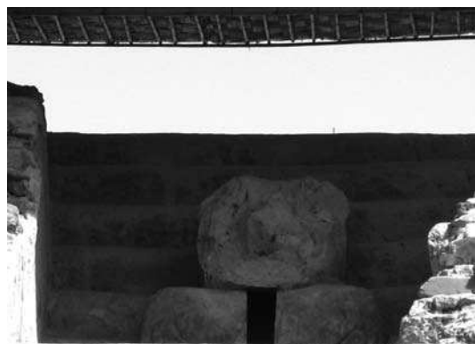
Figura 5. Estado actual del felino de Punkurí. Nótese el rostro destruido.
