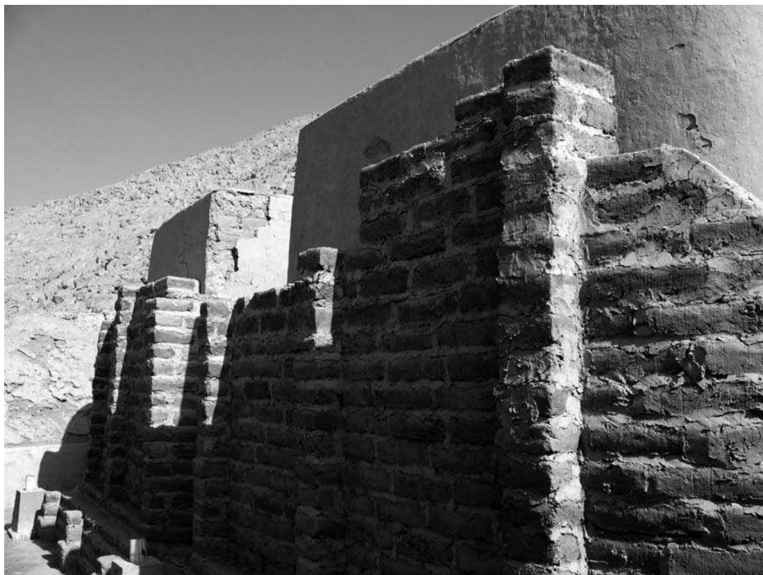
Figura 2. Fachada Norte del Templo de Barro de Cerro Sechín. Nótese los adobes que cubren los felinos. North facade of Mud Temple of Cerro Sechín. Look at adobe bricks that cover the painted felines.
