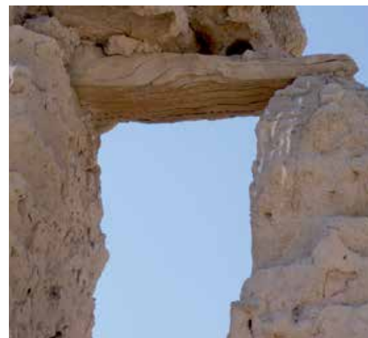
Detalle del vano de la kallanka . (Francisco Garrido, 2008).
