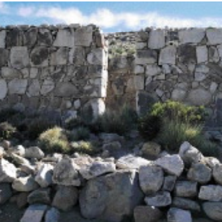
La arquitectura Inka se caracteriza por su patrón estrictamente rectangular y la perfección en el trabajo de la piedra. En edificios importantes los vanos eran trapezoidales, como es el caso del Tambo Chungara.
